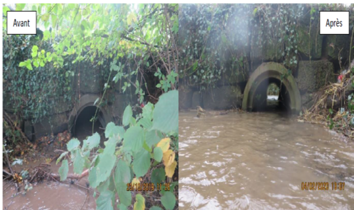
Embâcle présent sur la Brèche avant et après entretien
