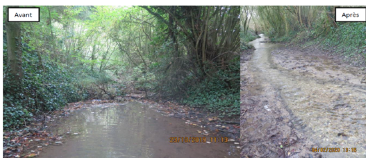
Embâcle présent sur la Brèche avant et après entretien
